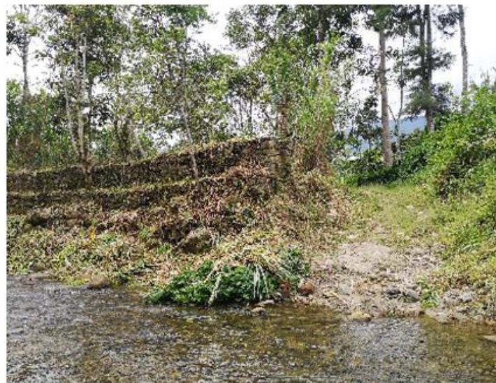
FIGURA N°03: TRAMO CRÍTICO EN EL RIO SHILPICACHI, EN EPOCAS DE LLUVIAS, SE INCREMENTA EL VOLUMEN DE AGUA GENERANDO EL DESBORDE DEL RIO EN SUS TRAMOS CON BORDOS MAS BAJOS, SE REQUIERE LA LIMPIEZA Y DESCOLMATACION.
